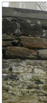
Bandeau en moellons de schiste horizontaux
