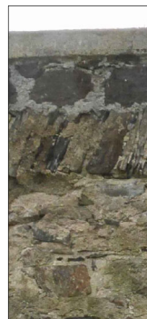
Bandeau en moellons de schiste verticaux
